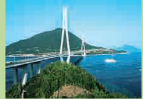
多々羅大橋
