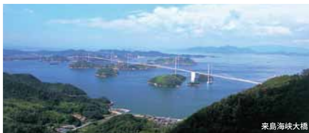
来島海峡大橋
