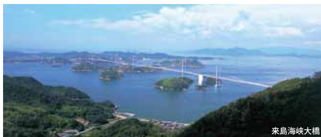
来島海峡大橋
